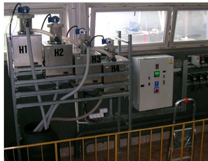
Instalacja do dawkowania enzymów wewnątrz budynku.
