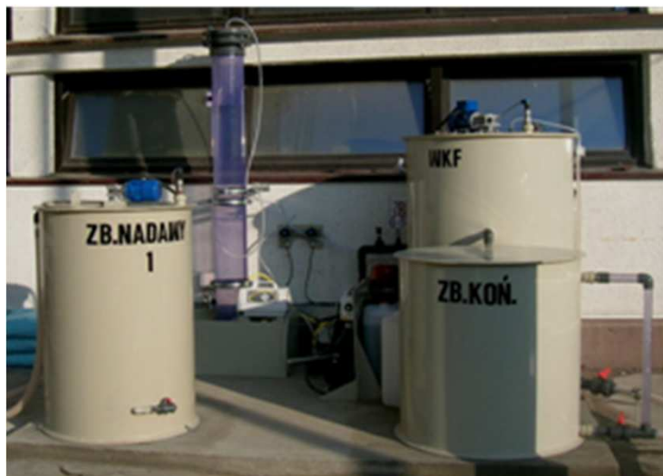
Zbiorniki umieszczone na zewnątrz budynku (bez wiaty).
