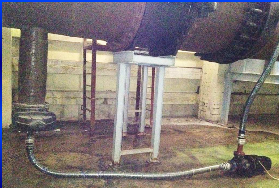
Popłuczyny pobierane z rurociągu – I etap
