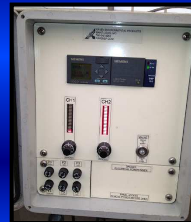
Pomiar wysokości osadu w osadniku
