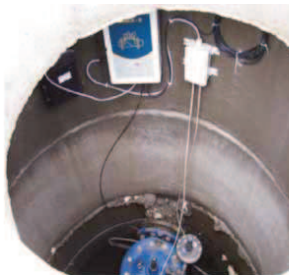
Fot. 2. Przykład zabudowy układu do sterowania zaworem redukującym ciśnienie w studzience
