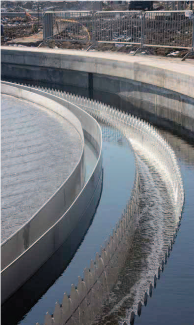
Agresywność środowiska pracy wymusza zastosowanie stali nierdzewnej
