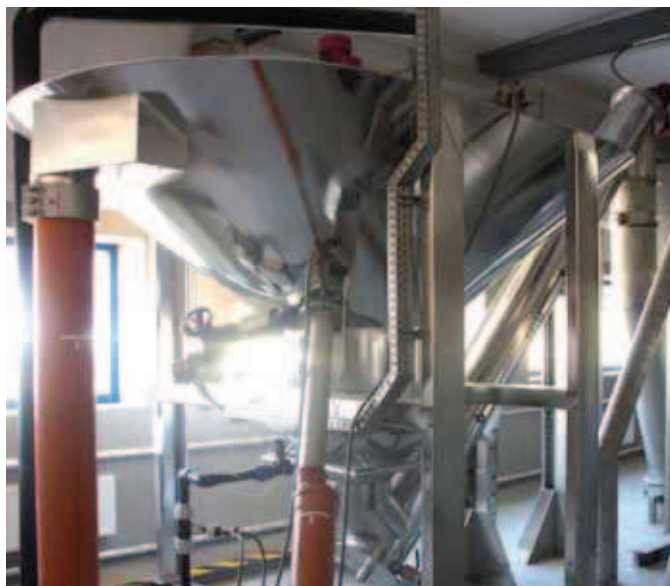
Na oczyszczalni zamontowane zostały dwa nowe separatory piasku firmy Meva-Pol. Są to dwa największe urządzenia tego typu, które firma dostarczyła na polski rynek
