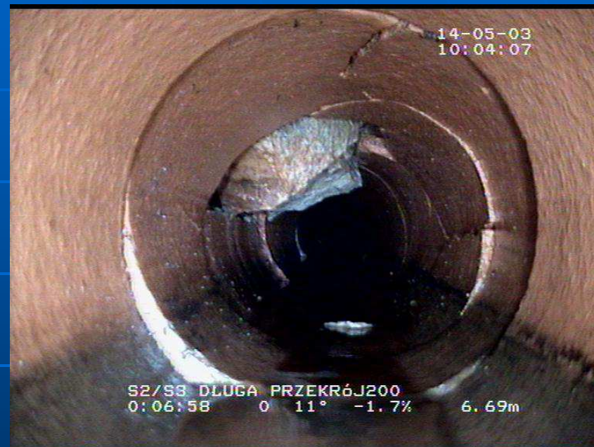
Kanał sanitarny w ul. Długiej
